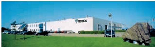
Завод в г. Вамдруп, Дания
